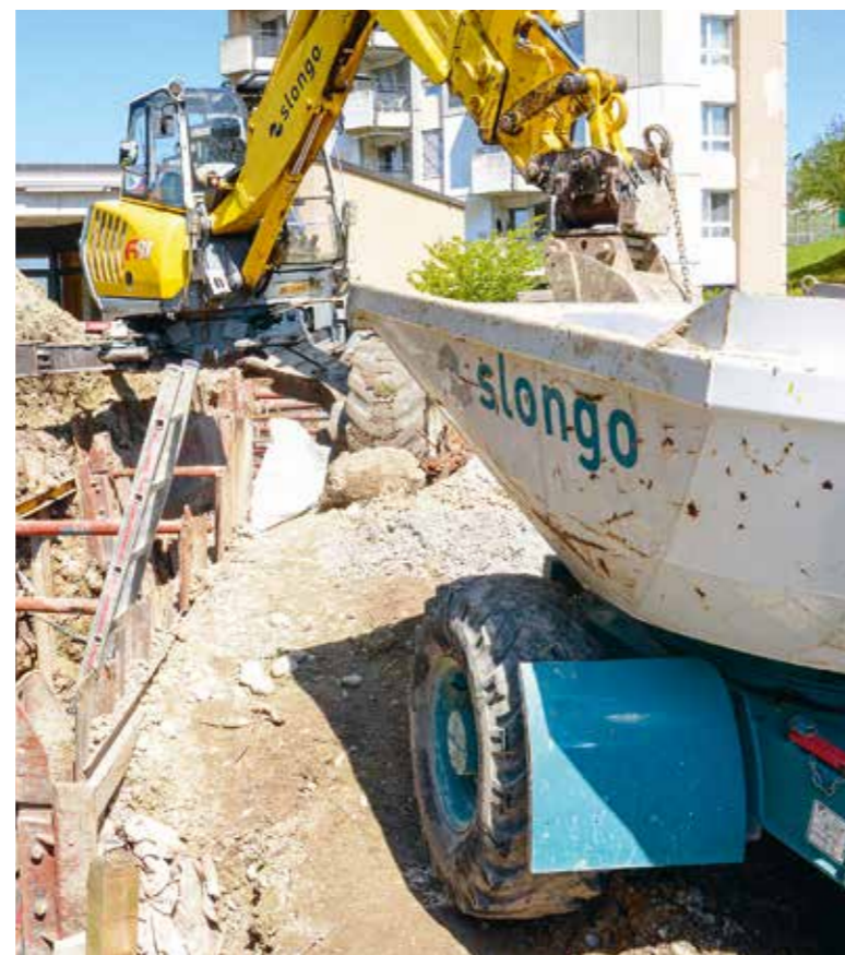
Der offene Kanal für die neuen Lüftungsrohre.
