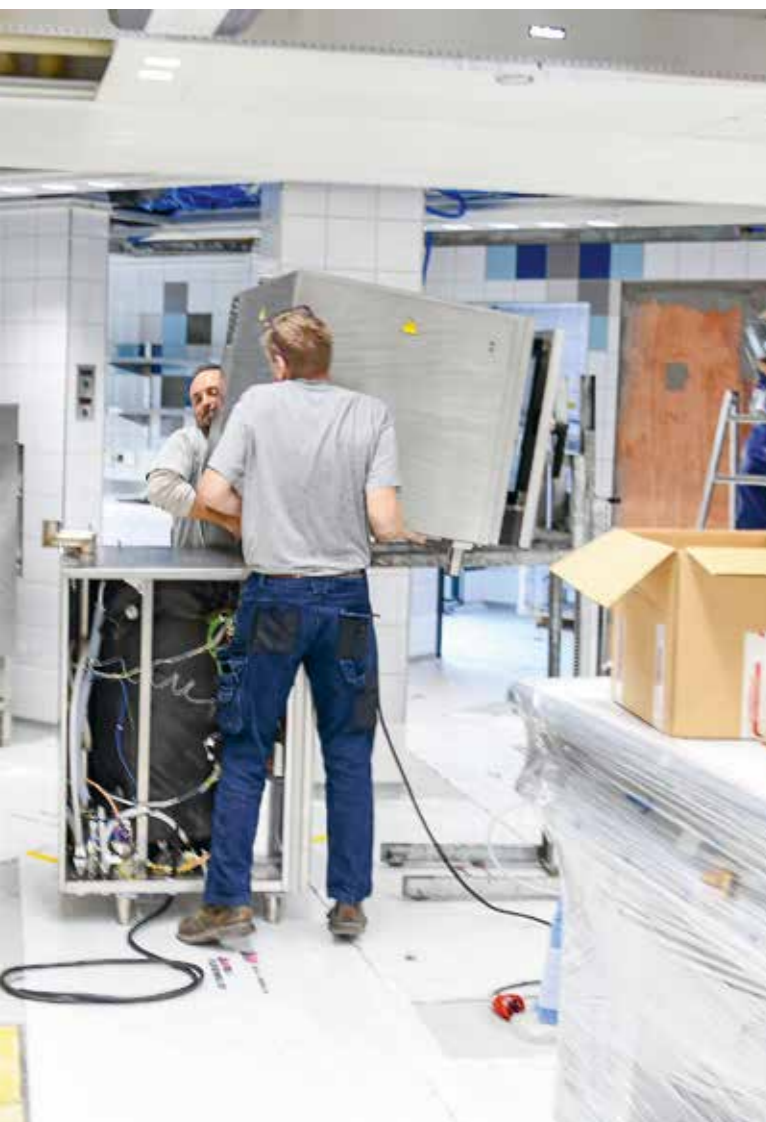
Installation der Hightech-Küchengeräte.
