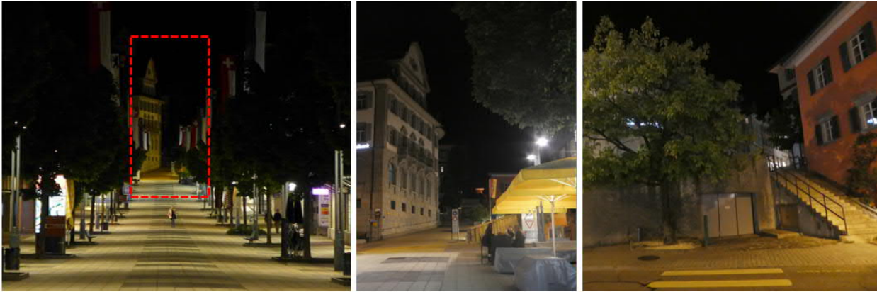
Abbildung 40: Aufgang Obere Bahnhofstrasse/ Weiherstrasse/ Toggenburgerstrasse
