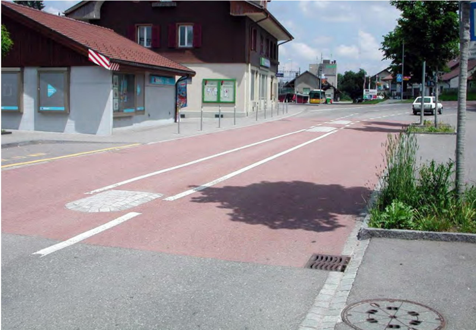
Abbildung 28: FGSO (farbliche Gestaltung von Strassenoberflächen), speziell ausgezeichnete Bereich für das flächige Queren, Bsp. Schwarzenburg (Quelle: Tiefbauamt Kanton Bern)
