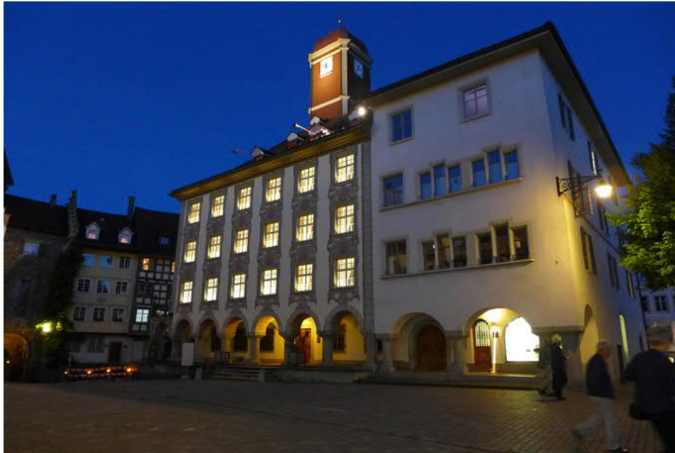
Abbildung 50: Beleuchtung Stadtarchiv (Nordseite)
