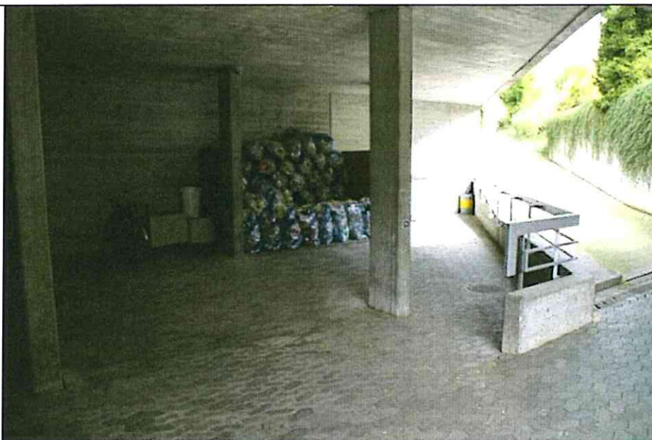
Velounterstand Lindenhofschule (bestehende Kamera 602)
