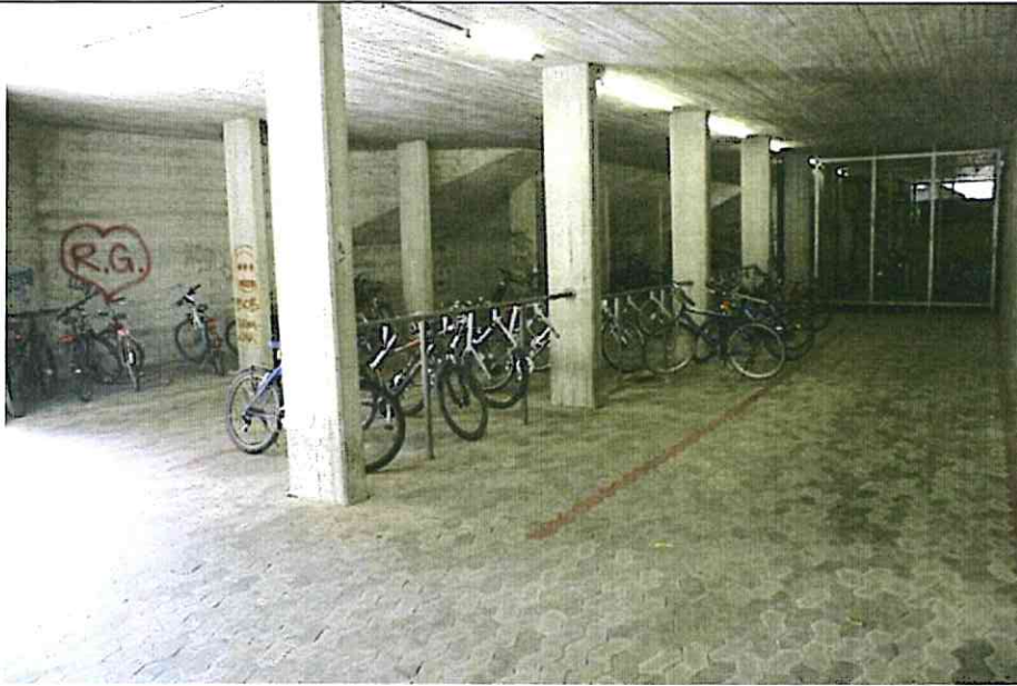
Velounterstand Lindenhofschule (bestehende Kamera 603)
