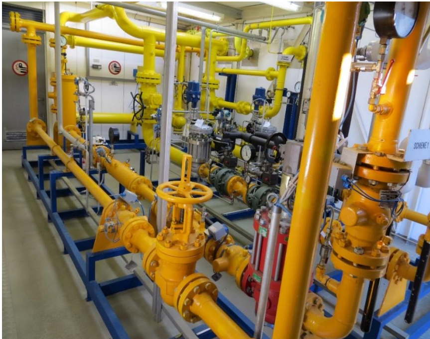
Abbildung 1: DRM Busswil Innenverrohrung bestehend seit 1987
