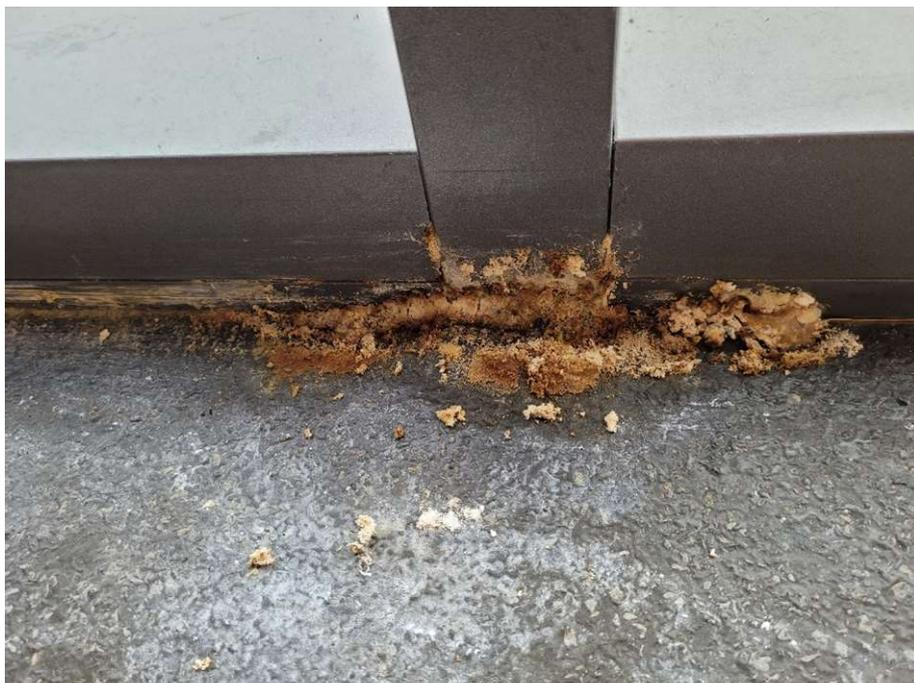
*3 FG03 Detail Materialkrümel quellen aus Fuge der Riegel*
