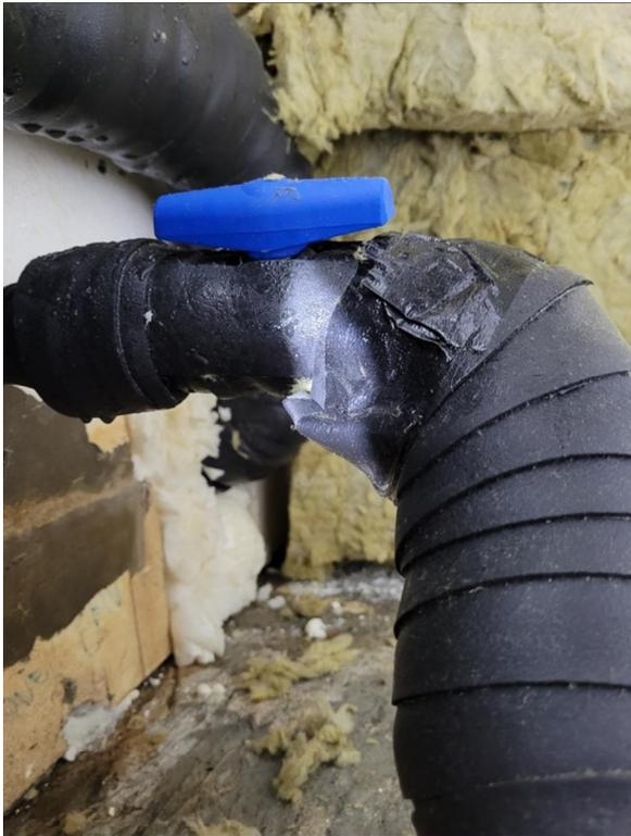
6 TB05 Kondensat innerhalb Leitungsdämmung
