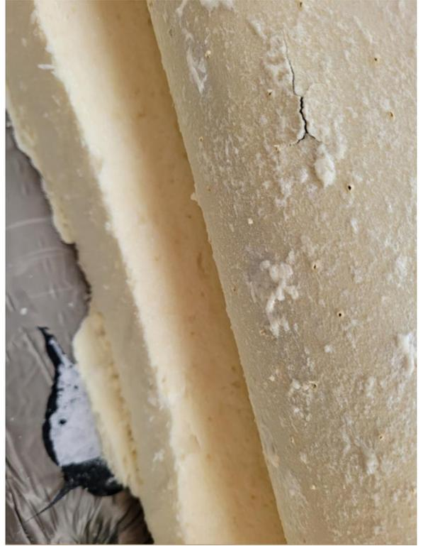
2 S02 Lose Unterdachfolie auf PU-Dämmung Sockel
