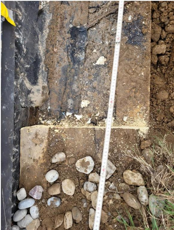
11 S11 Dämmstreifen mit Geröllstreifen, Korn bis 30 mm
