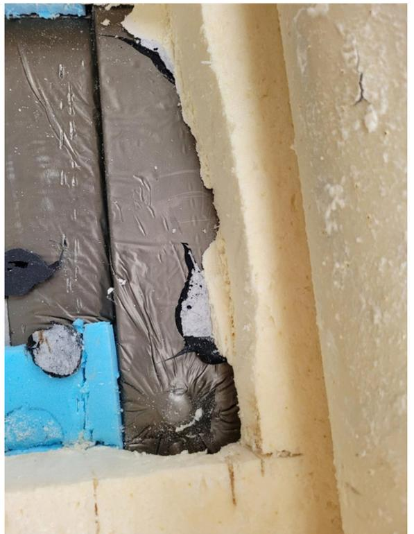
4 S04 Innere Abdichtung mit plastifiziertem Bitumenband
