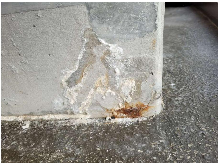
3 BS03 Detail Korrosion, grossflächige Kosmetik, Pilzbefall
