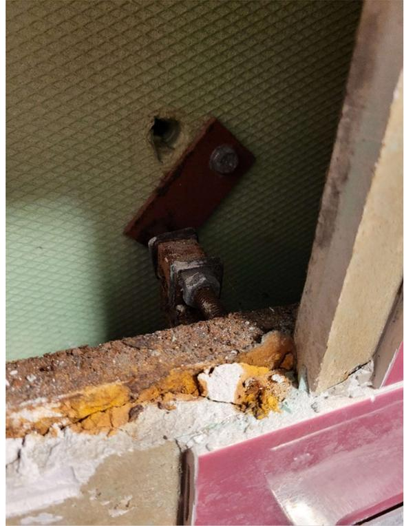
5 DU06 verkorrodierte Unterkonstruktion
