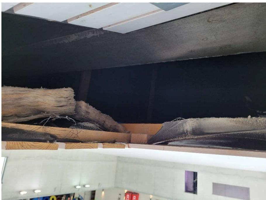
3 LH03 Seitliche Deckenkonstruktion mit Akustikdämmung
