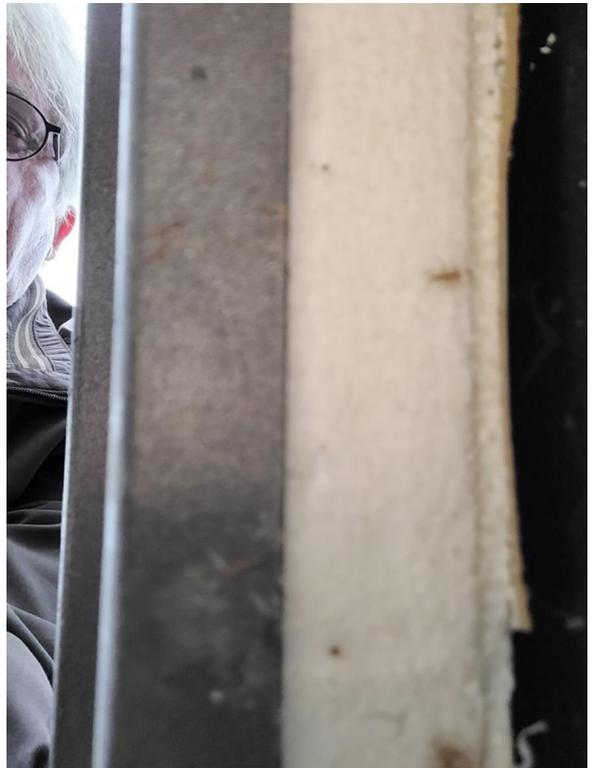
10 S10 Sockelblech gefüllt mit PU-Dämmung
