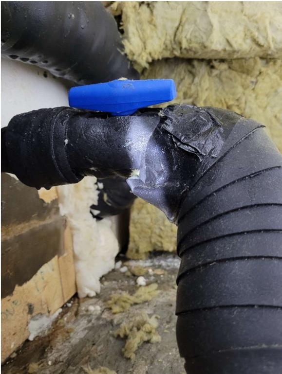
6 TB05 Kondensat innerhalb Leitungsdämmung
