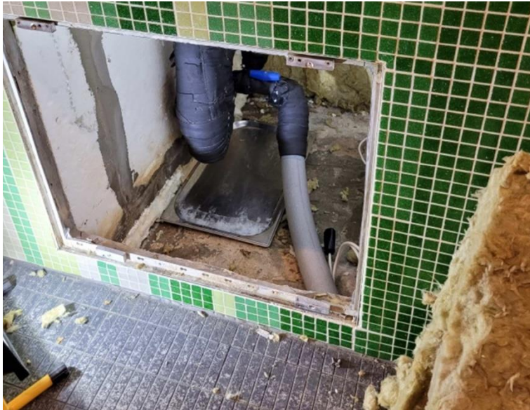
Abb. 2: Revisionsöffnung unter dem Kaltwasserbecken
