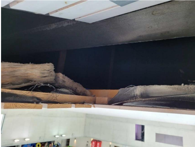
Abb. 8: Aufbau im Hohlraum über der Decke des Hallenbads
