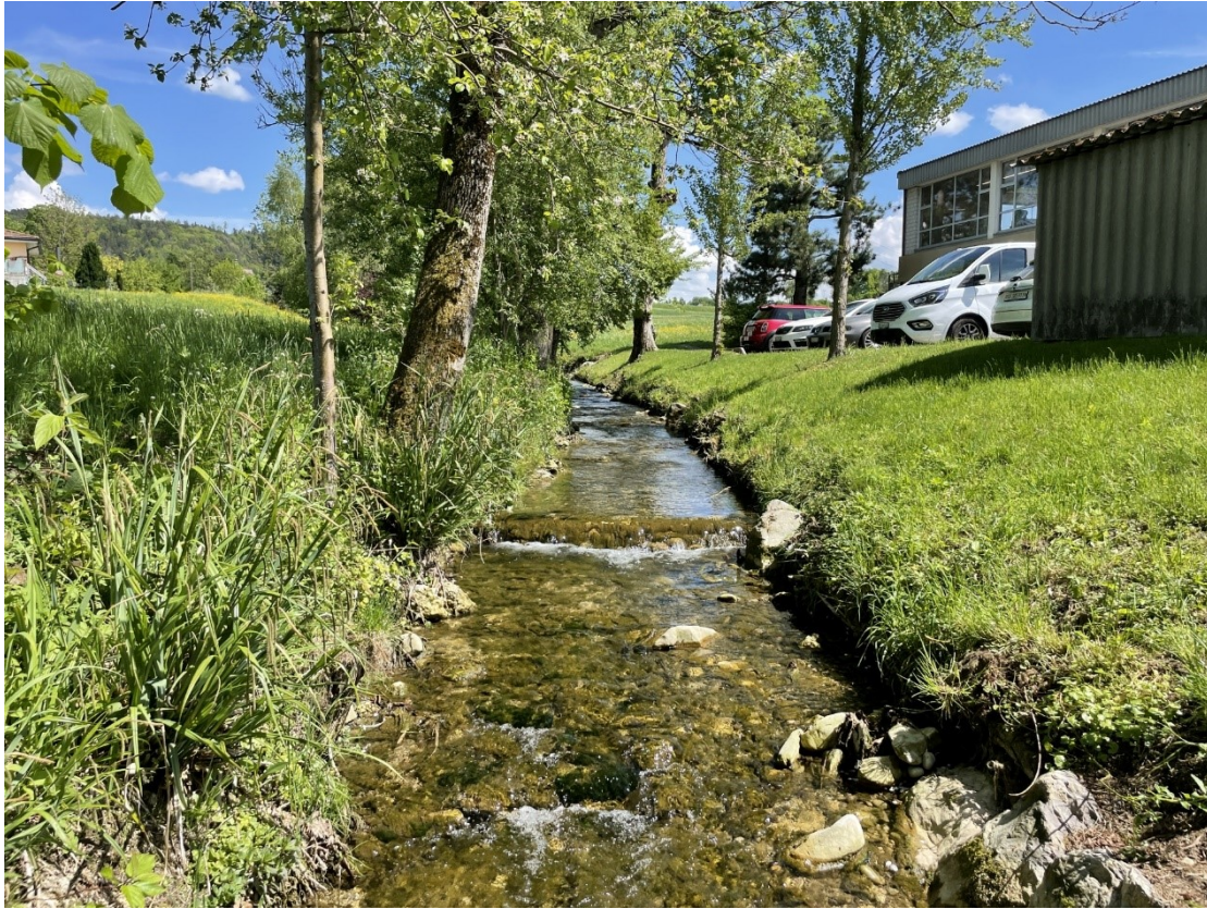
Profil 4; bestehende Gerinne und Uferbestockung, Schwelle, Blickrichtung bachaufwärts
