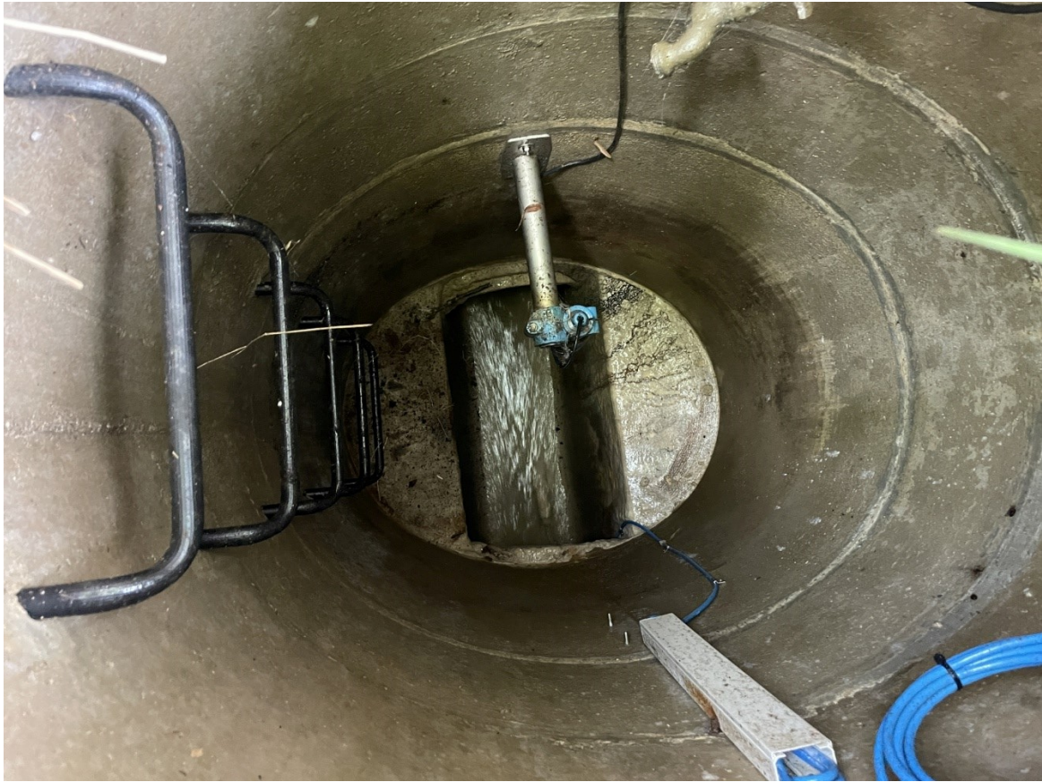
Kontrollschacht KS 12196-B, Mischwasserwasserleitung
