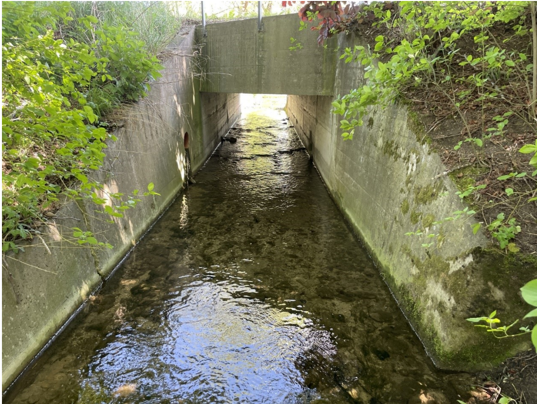
Profil 7; Durchlass AMP-Strasse, Auslaufbereich, Blickrichtung bachaufwärts
