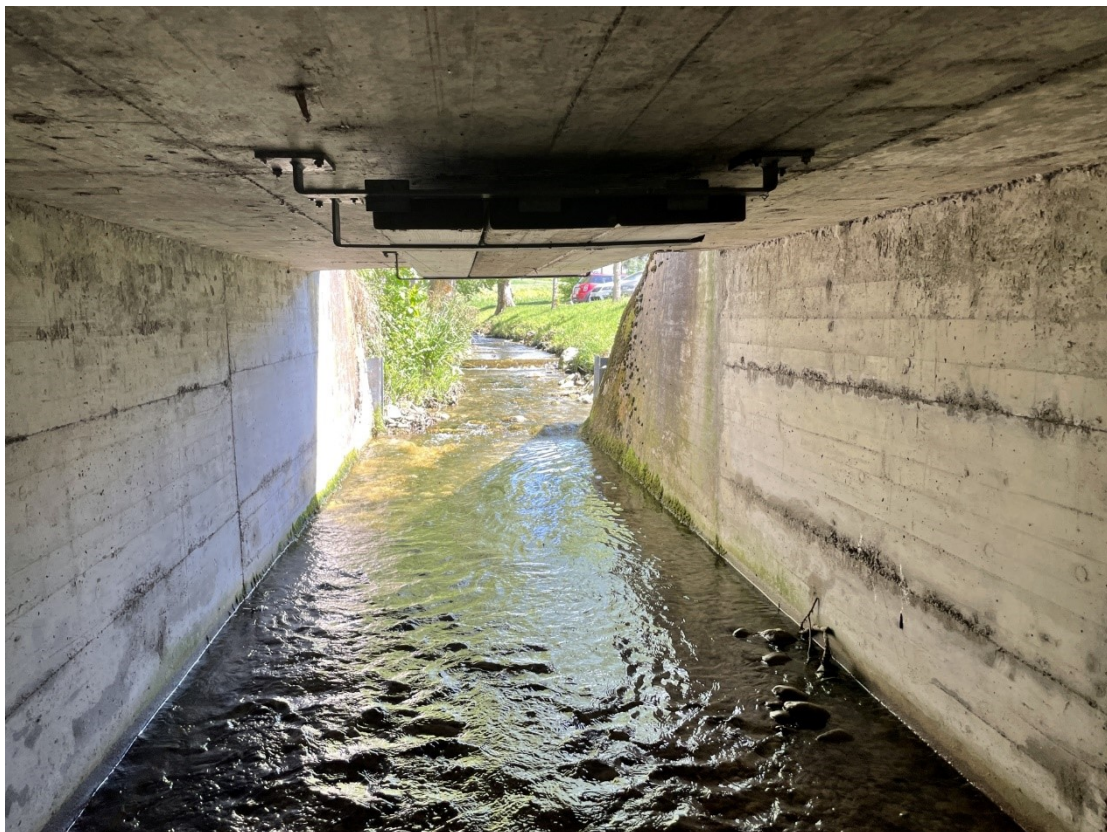
Profil 5; Durchlass AMP-Strasse, Blickrichtung bachaufwärts
