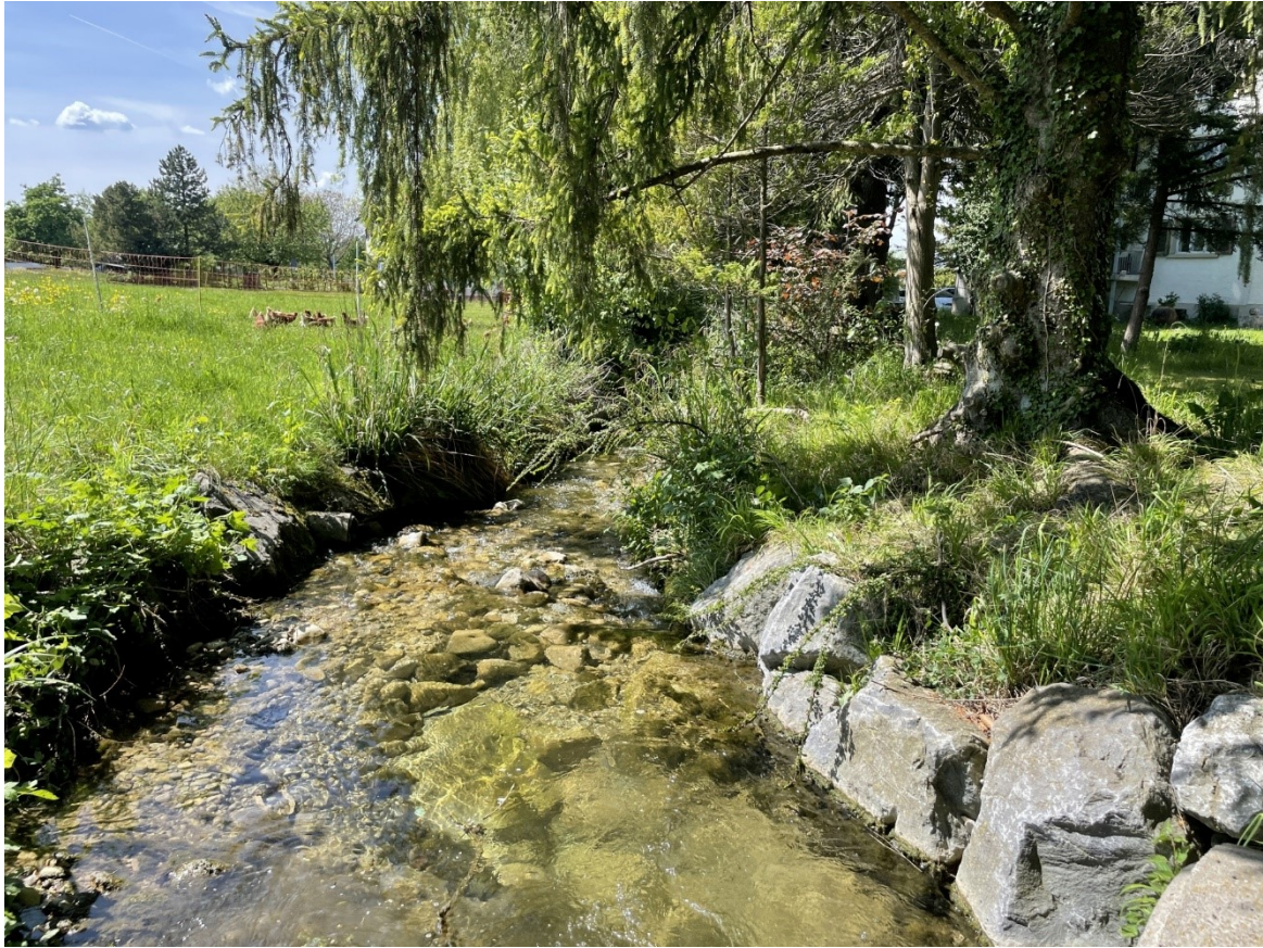
Profil 8; bestehendes Gerinne mit rechtsufrigen Uferverbauungen, Blickrichtung bachabwärts
