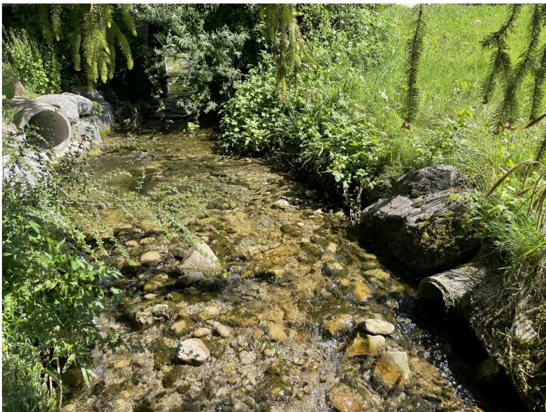
Profil 8; Ableitung (Überlauf) Regenbecken, Blickrichtung bachaufwärts
