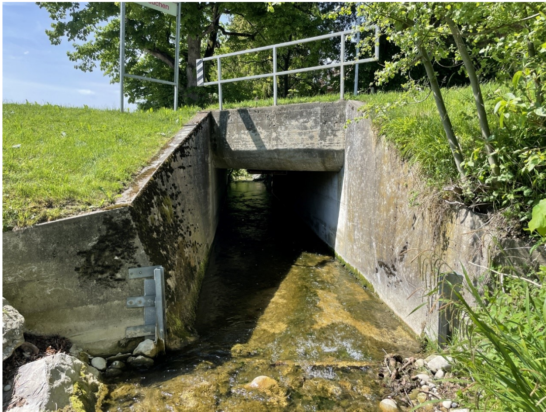
Profil 4; heutiger Durchlass AMP-Strasse, Einlaufbereich, Blickrichtung bachabwärts
