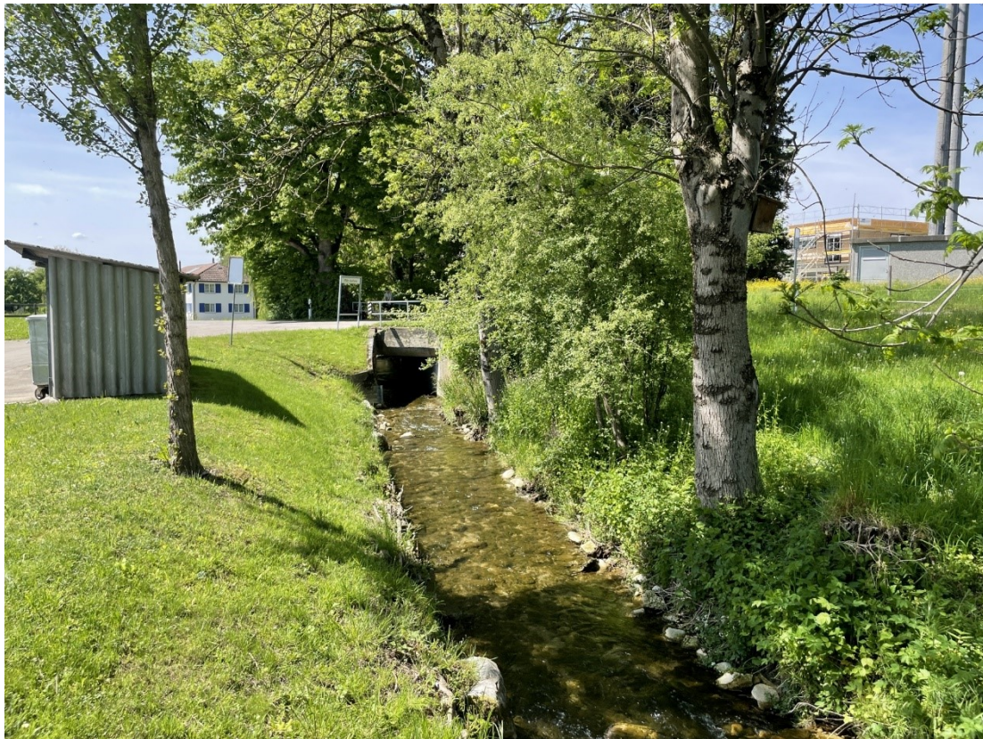
Profil 2; bestehende Gerinne und Uferbestockung, Blickrichtung bachabwärts
